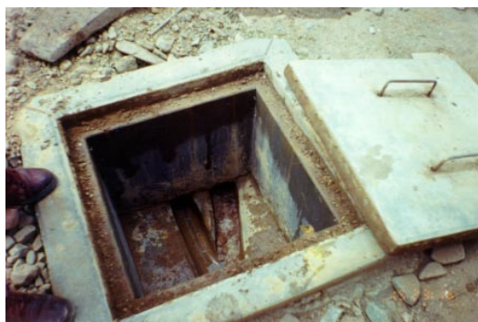
Figura 5 - Caja de Inspección Condominial de Mampostería
